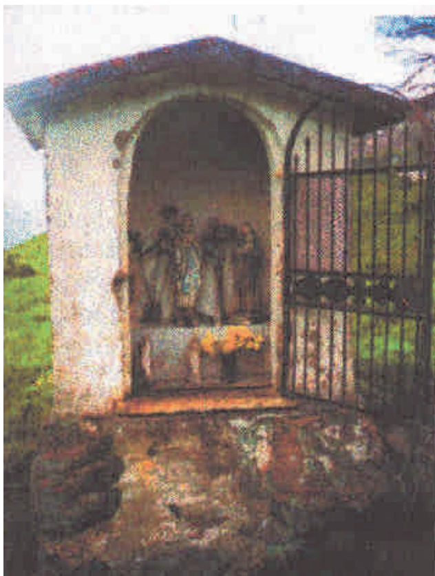
Img. A.7.22: Oratorio nella Frazione di Chassàn
